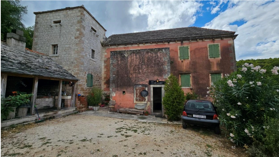
Slika 11. Sjeveroistočni dio kompleksa s kulom
