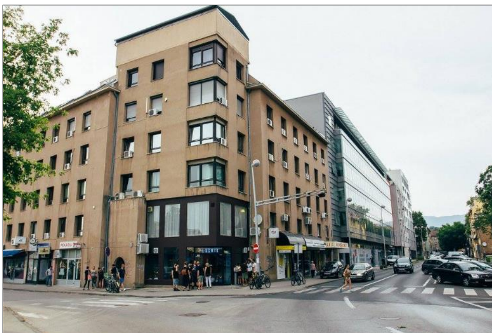
Slika 4 — Zgrada u Međimurskoj ulici, na čijem se uglu u prizemlju i podrumu nalazi Pločnik
