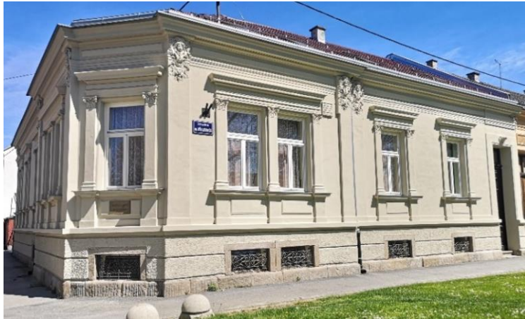
Slika 8: Današnji izgled zgrade Češke obeci Bjelovar (Izvor: iz vlastitog arhiva)
